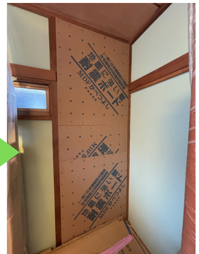
耐震ボードを 施工
