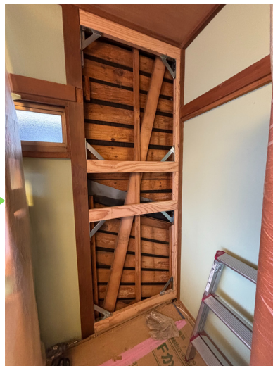
解体後耐力 下地取付
