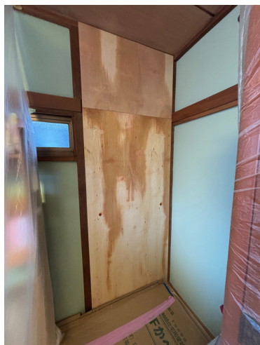
合板施工取付
