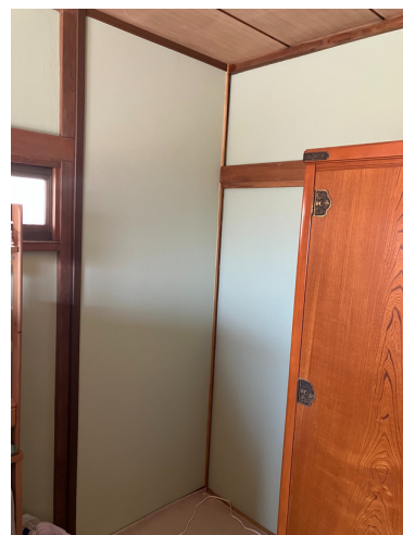
クロスを貼り 完成
